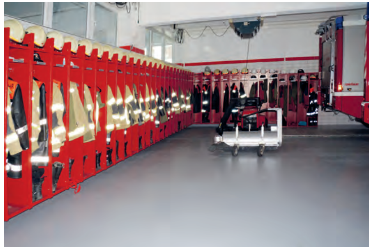
Der pflegeleichte Industrieboden in der Feuerwehrrhalle wurde neu verlegt
