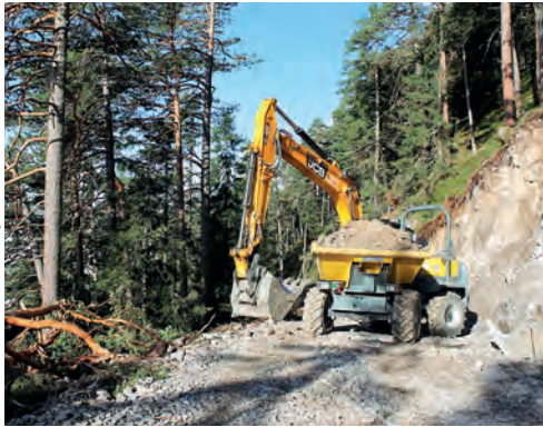
Schutzwaldweg Gröbenweg in Bau
